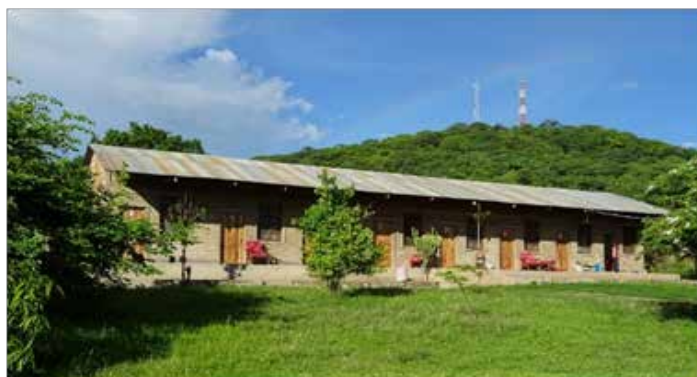
Maison d'accueil à Kipili
