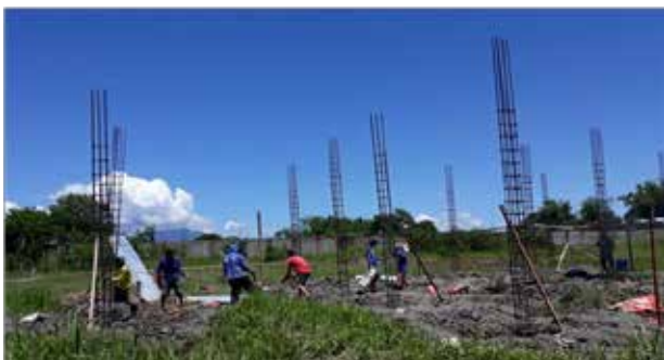
Démarage du chantier en septembre 2018
